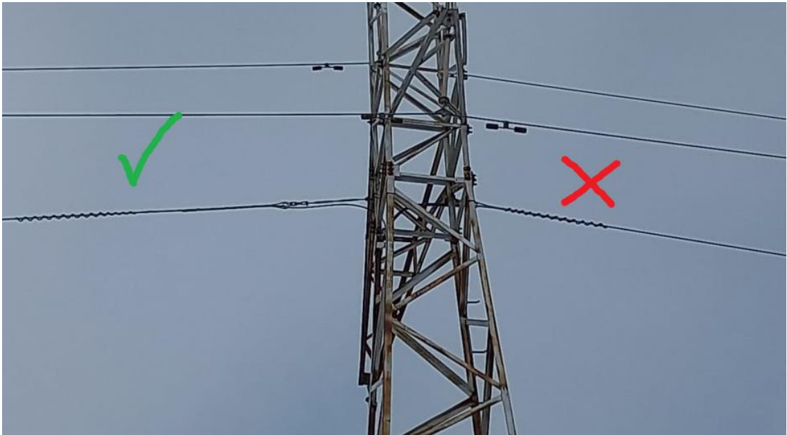
Рисунок 1. Правильная и неправильная установка спиральных ГВН
