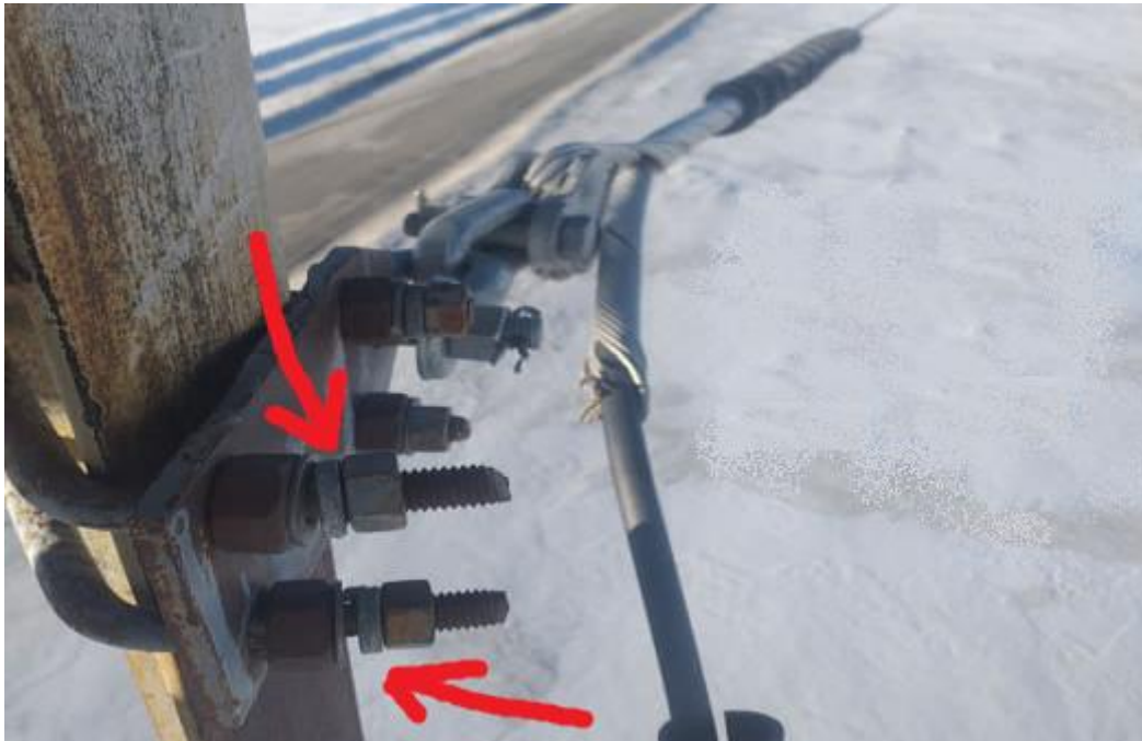
Рисунок 2. Пример проблемы с креплением кабеля ВОЛС
