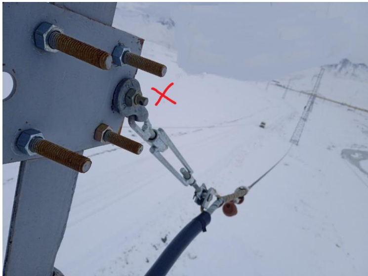
Рисунок 4. Пример проблемы с креплением кабеля ВОЛС
