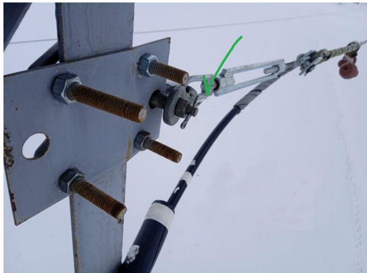
Рисунок 3. Пример правильного крепления кабеля ВОЛС
