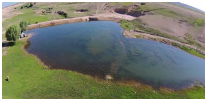
Lipenka (Kabak) pump station
